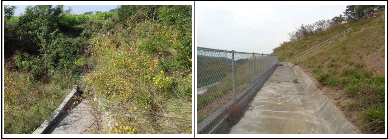
【그림 5.3.3】 배수시설 전경
