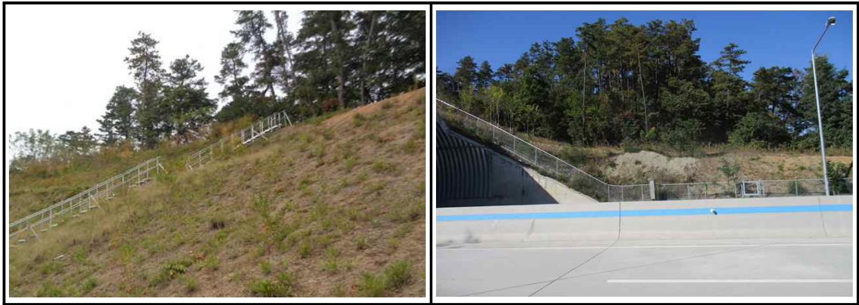
【그림 5.3.1】 상부자연사면 전경
